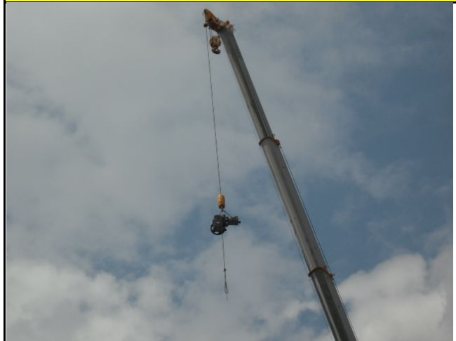
2011. 8.22 機械室各機器搬入・搬出
