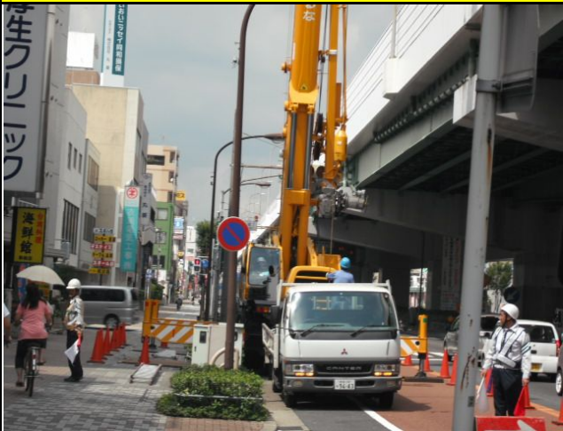
2011. 8.22 機械室各機器搬入・搬出
